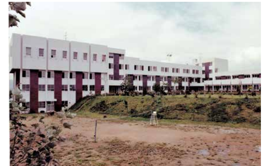
1988. 연구원 출범 당시 건물(농수산물유통공사 유통교육원)
